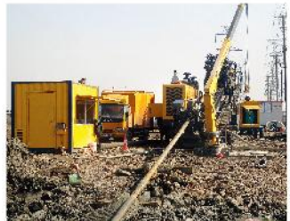
XZ3000水平定向钻机在武汉施工 XZ3000 HDD working in Wuhan
